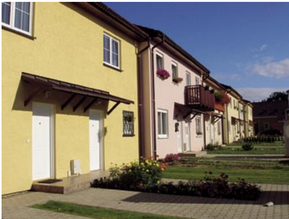
Obr. 1.27 Ekonomická řadová zástavba je vhodnou alternativou k bydlení v panelovém bytovém domě [1]
