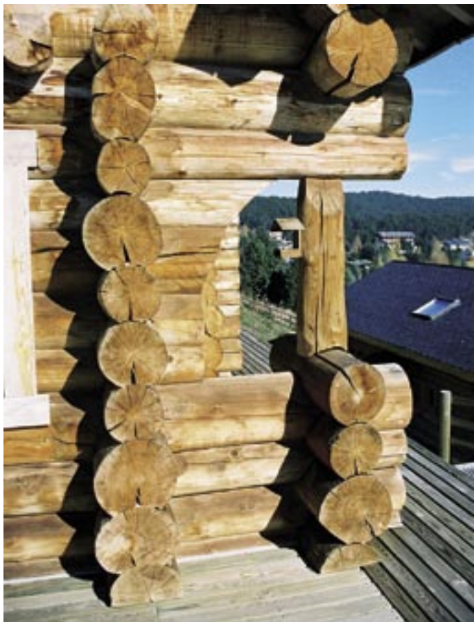
Obr. 2.9 Spoj nehraněného srubu v místě ložní spáry s výřezem tvaru U [43]
