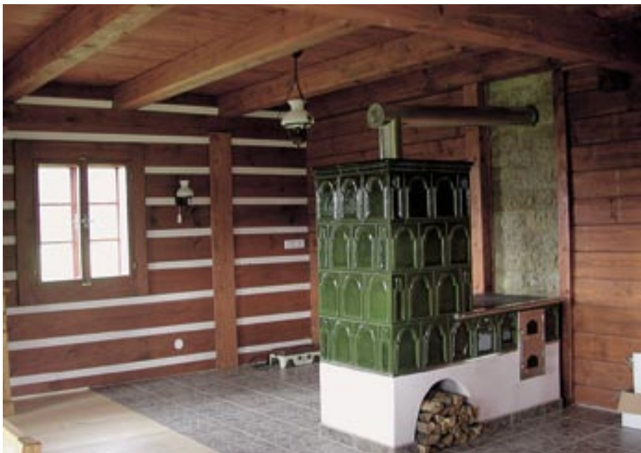
Obr. 4.28 Vhodné řešení napojení kachlových kamen na komín [17]
