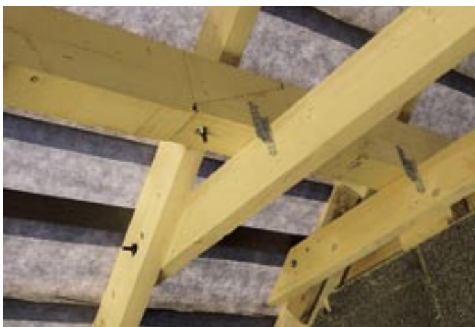
Obr. 2.58 Osedlání vaznice ve spojení s kleštinou [1]
