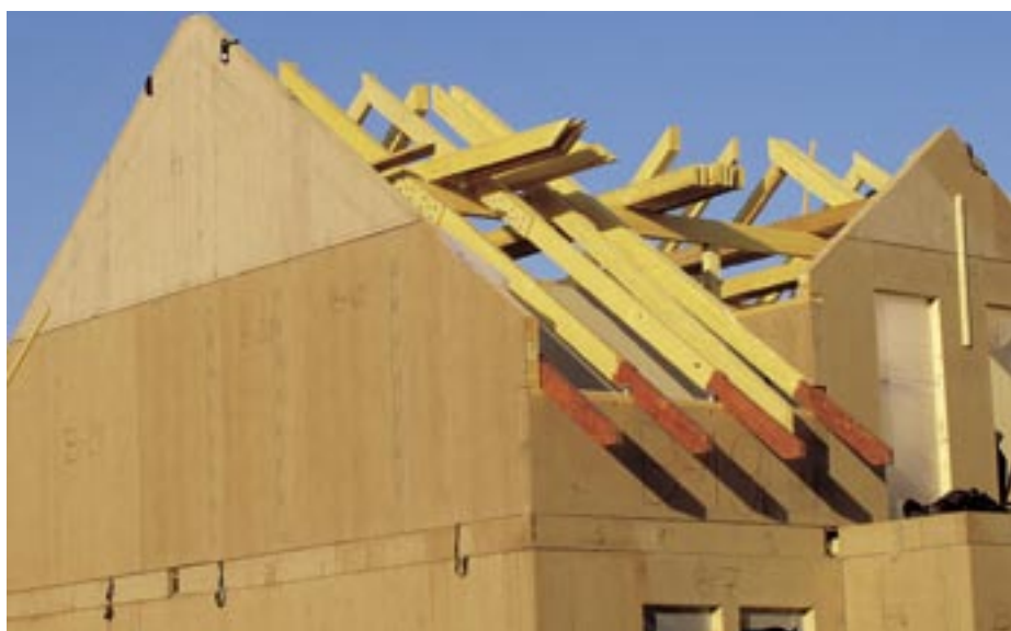
Obr. 4.17 Montáž konstrukce krovu [2]
