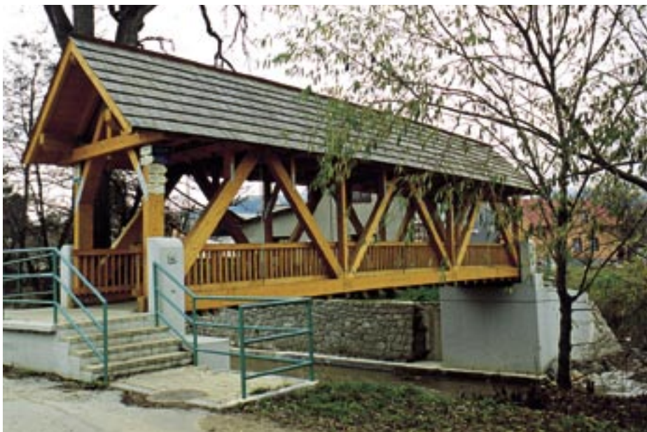
Obr. 4.50 Lávka ve Vikýřovicích [1] (NOVÝ)
