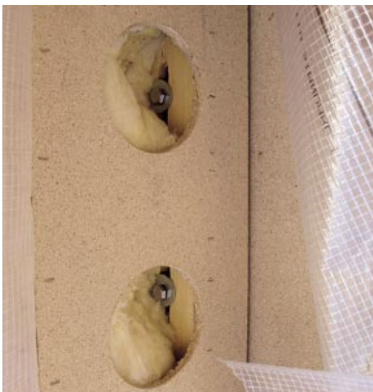
Obr. 4.8 Spoje panelů pomocí svorníků [2]
