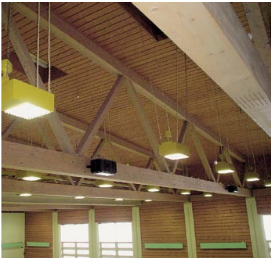
Obr. 4.46 Vazníky se styčníky z vložených ocelových plechů [7]
