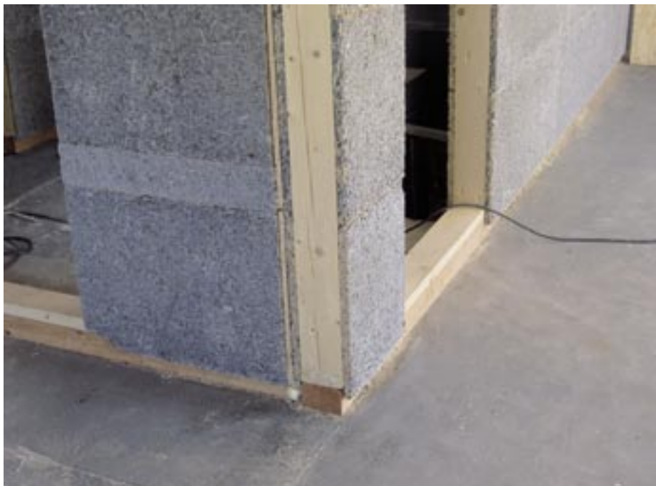
Obr. 3.12 Dřevocementové desky jako uzavírací podklad pod omítkou [1]
