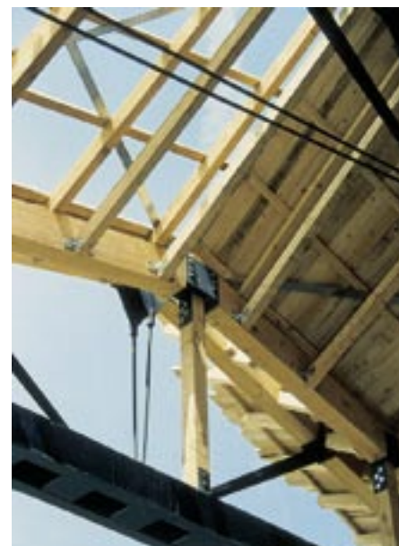
Obr. 3.20 Kovové spojovací přípravky ve velkorozponové konstrukci [1]
