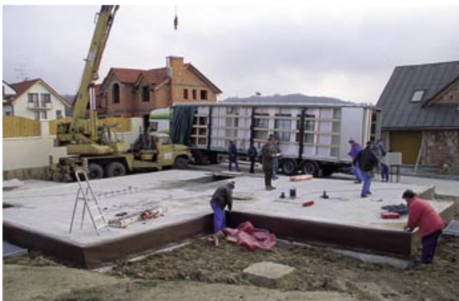
Obr. 4.2 Panely dovezené na staveniště těsně před montáží [4]
