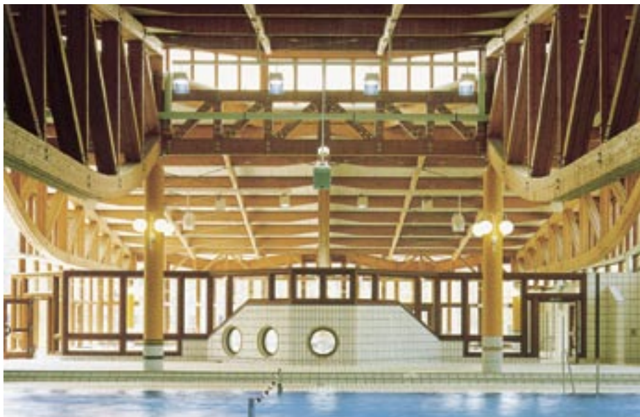
Dřevo je svými vlastnosti předurčeno k zastřešení sportovních objektů (plovárna Rothelheim-Bad, Erlangen) [22]
