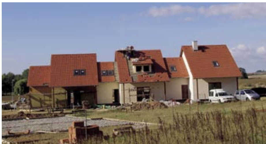
Obr. 4.5 Finální úprava montovaného objektu [2]
