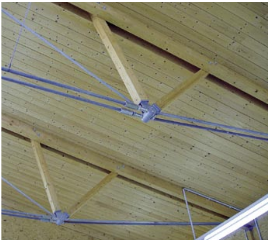
Obr. 2.73 Detail spřaženého vazníku [1]
