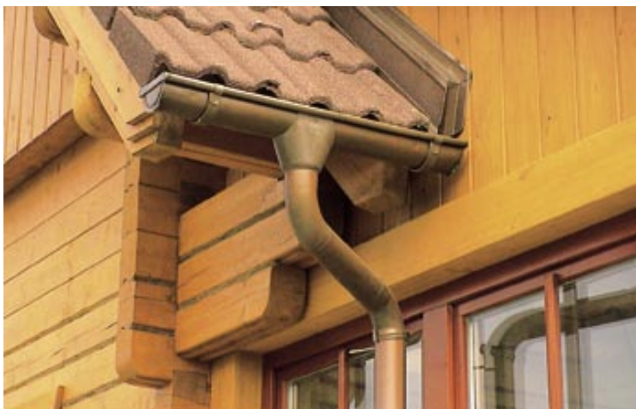
Obr. 2.6 Detail alternativního rohového spoje hraněného srubu [8]
