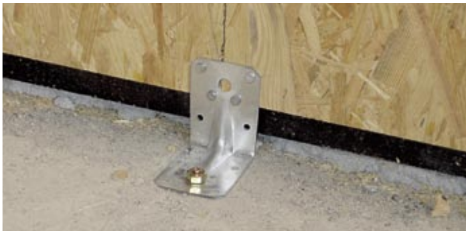
Obr. 4.6 Kotvení základového prahu [1]
