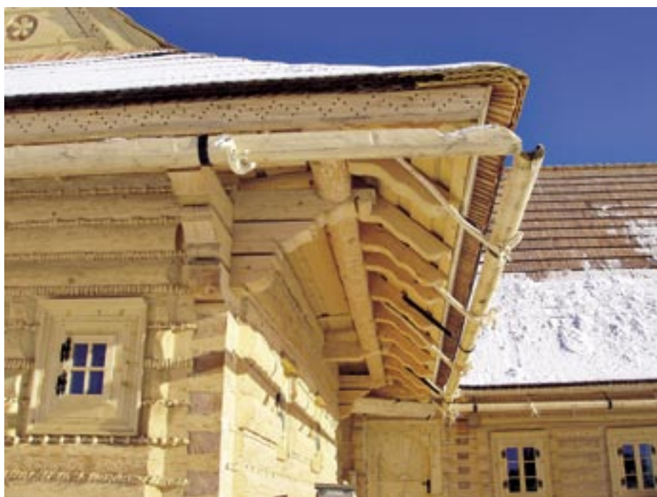
Obr. 2.11 Polohraněná konstrukce srubu [1]
