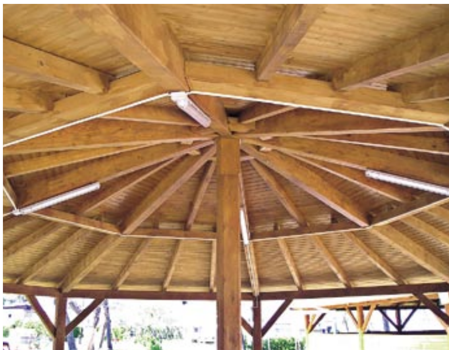
Obr. 4.44 Zajímavě řešená střešní konstrukce zahradního altánu [(Drevodom Orava)]
