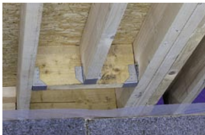
Obr. 2.49 Trémová výměna v místě komínu [2]
