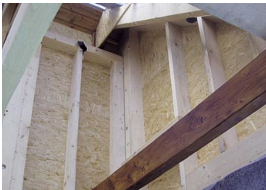
Obr. 3.11 Konstrukce s deskami OSB [1]
