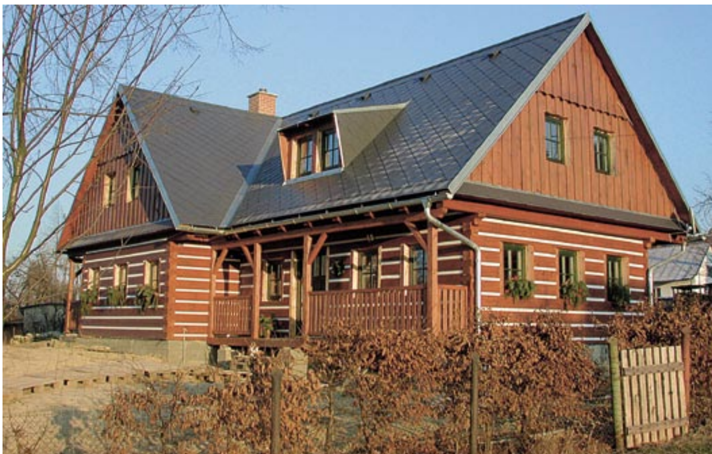
Obr. 4.32 a 4.33 Současné rekreační srubové stavby navazující na původní architekturu [Drevodom Orava,17]
