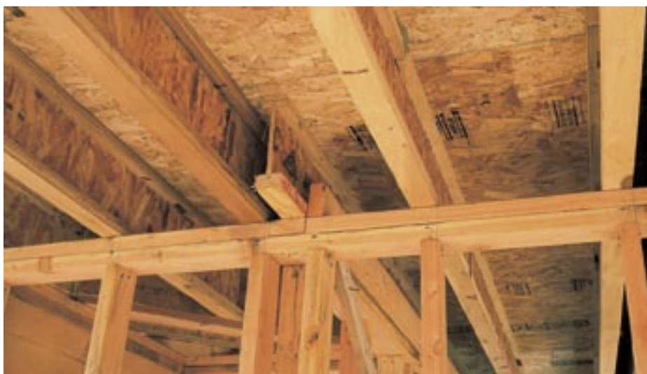
Obr. 2.51 Stropní konstrukce s I-profilý [5]
