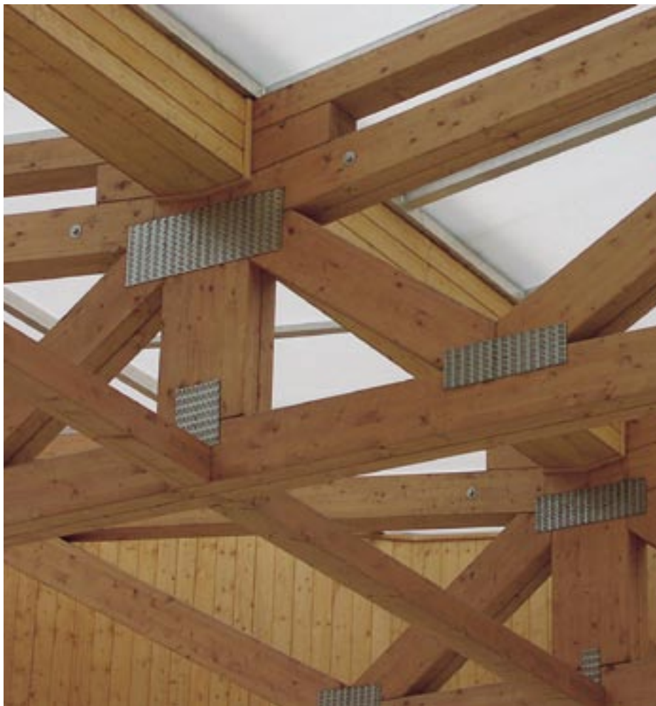
Obr. 4.45 Příklad vazníku s deskami s prolisovanými hroty [22]
