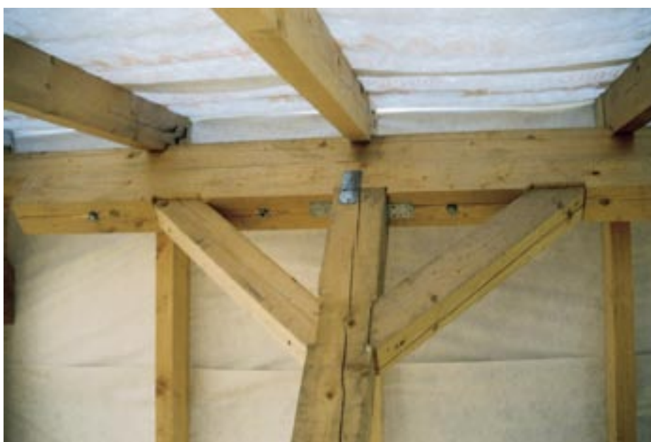
Obr. 2.56 Podepření vrcholové vaznice sloupkem, zavětrování diagonálními pásky [8]
