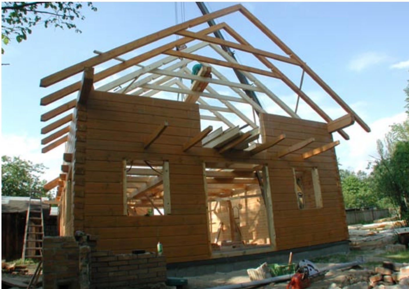
Obr. 4.41 Montáž celého hambalkového rámu [17]
