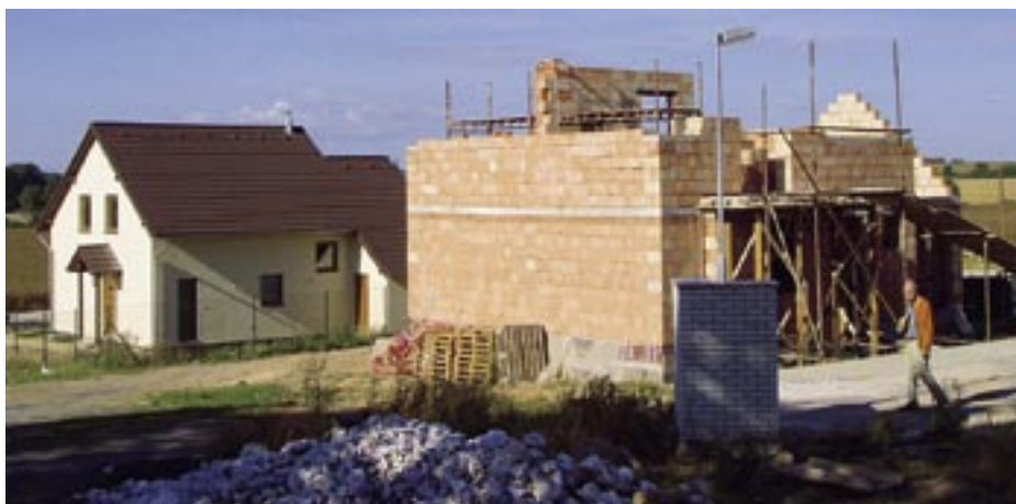
Obr. 1.28 Porovnání doby výstavby v praxi (dřevostavba v pozadí je již zabydlená) [1]
