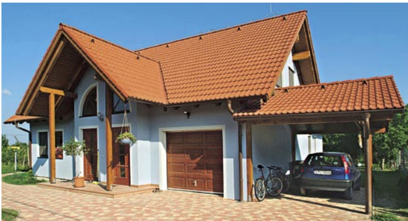
Obr. 1.26 Panelový rodinný dům na bázi dřeva s nízkou spotřebou energie – opláštění kontaktní fasádou zabezpečí fyzikální celistvost, tepelnou a akustickou ochranu [4]
