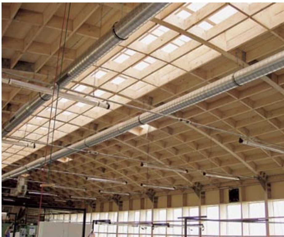
Obr. 4.48 Zastřešení haly lamelovou skořepinou [1]
