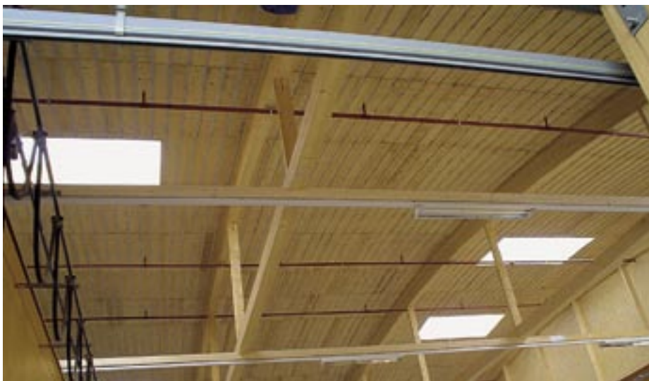
Obr. 3.6 Obloukový vazník z lepeného dřeva [7]
