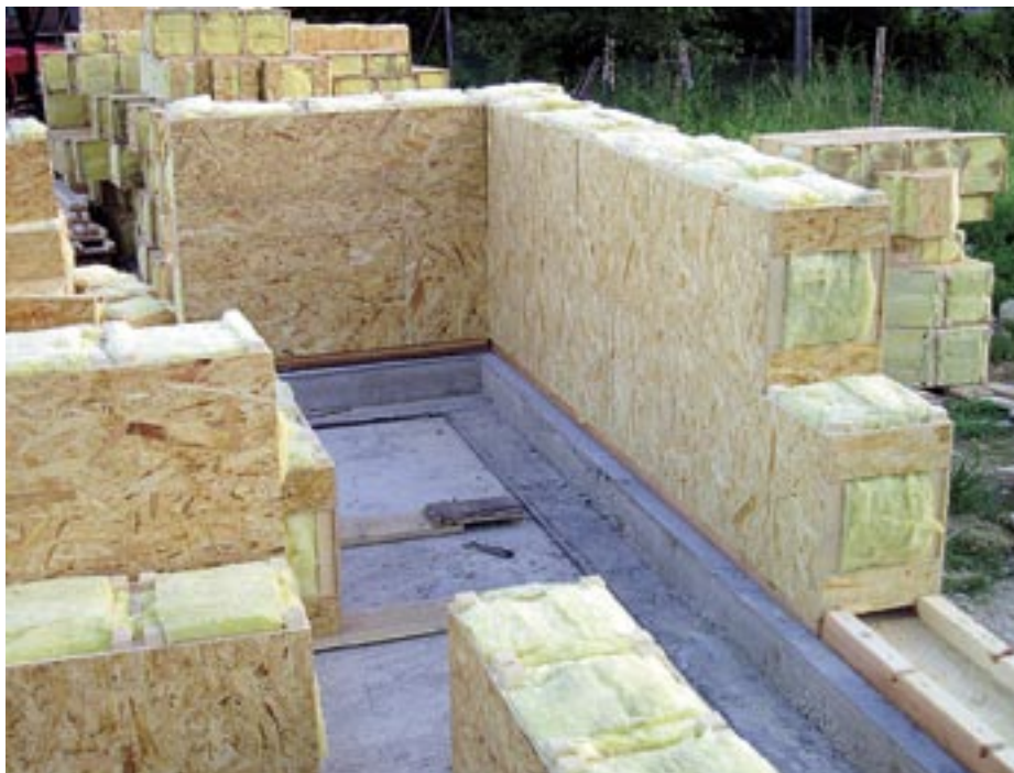
Obr. 2.37 Stěna z prefabrikovaných tvarovek pro pasivní dům [1]
