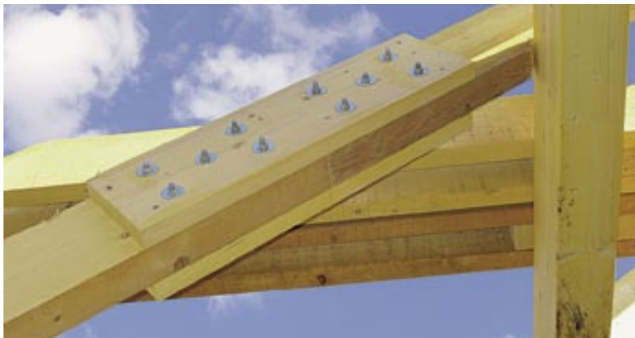
Obr. 3.19 Spoj s příložkami [2]
