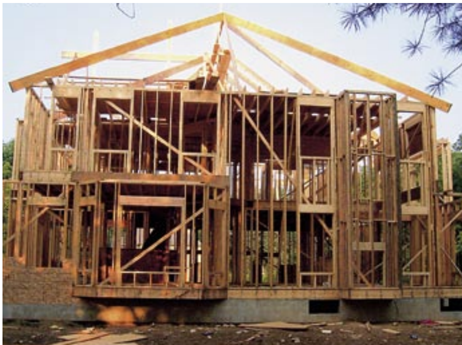
Obr. 2.23 Příklad výstavby v sloupkové soustavě [5]
