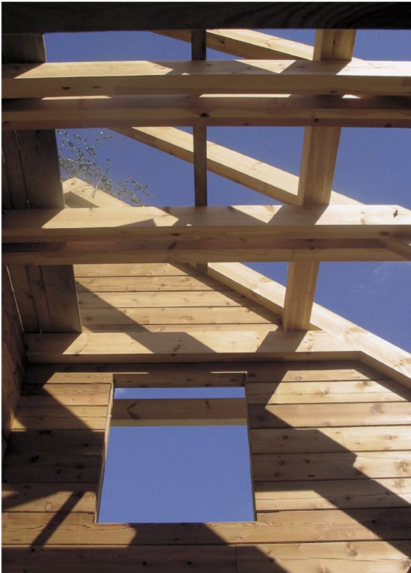
Obr. 2.67 Hambalkový krov vyztužený vaznicí [17]
