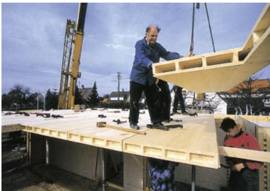
Obr. 2.52 Strop z lepených dutých tvarovek [27]
