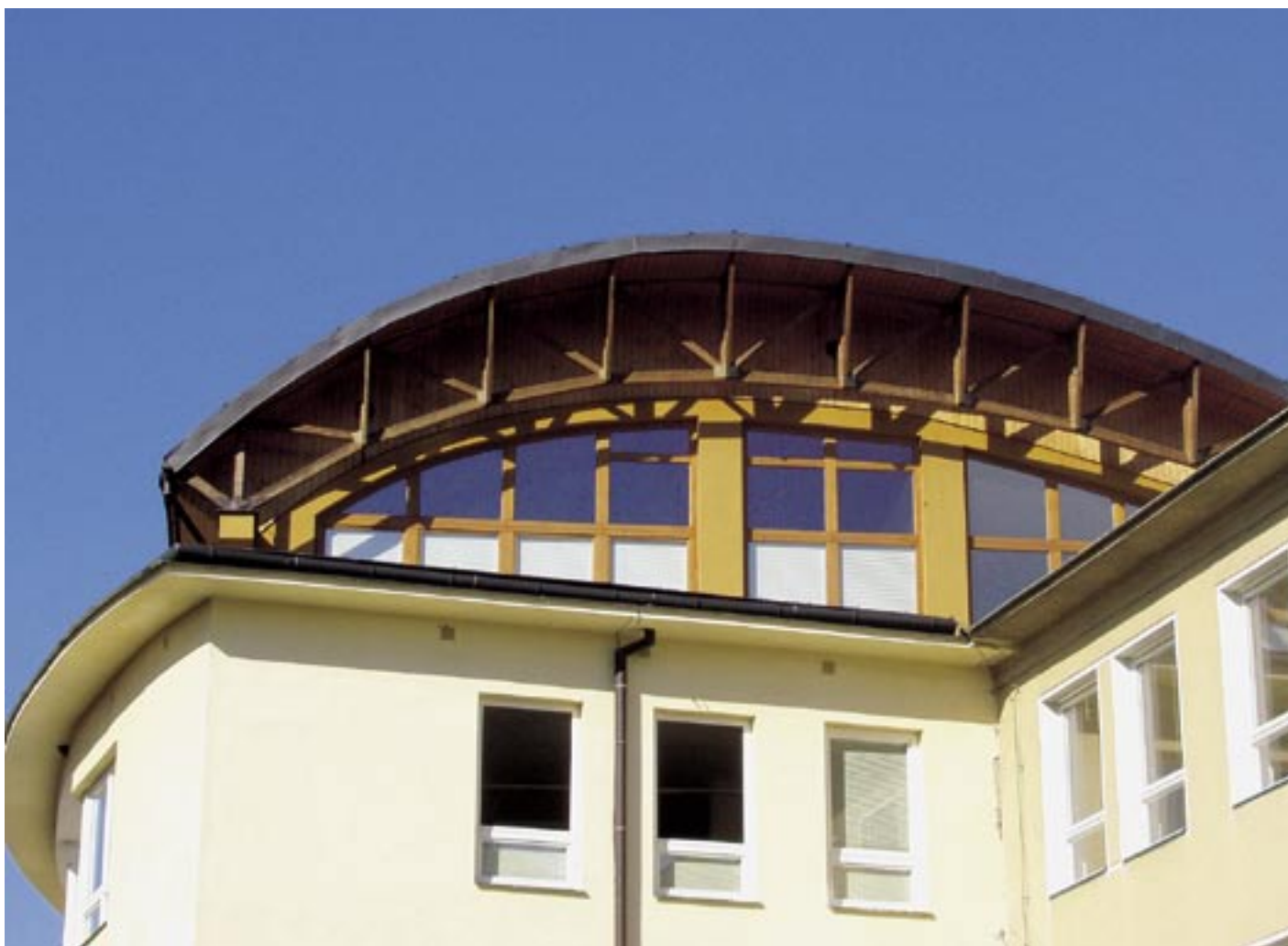
Obr. 2.74 Přiznaný obloukový příhradový vazník [1]
