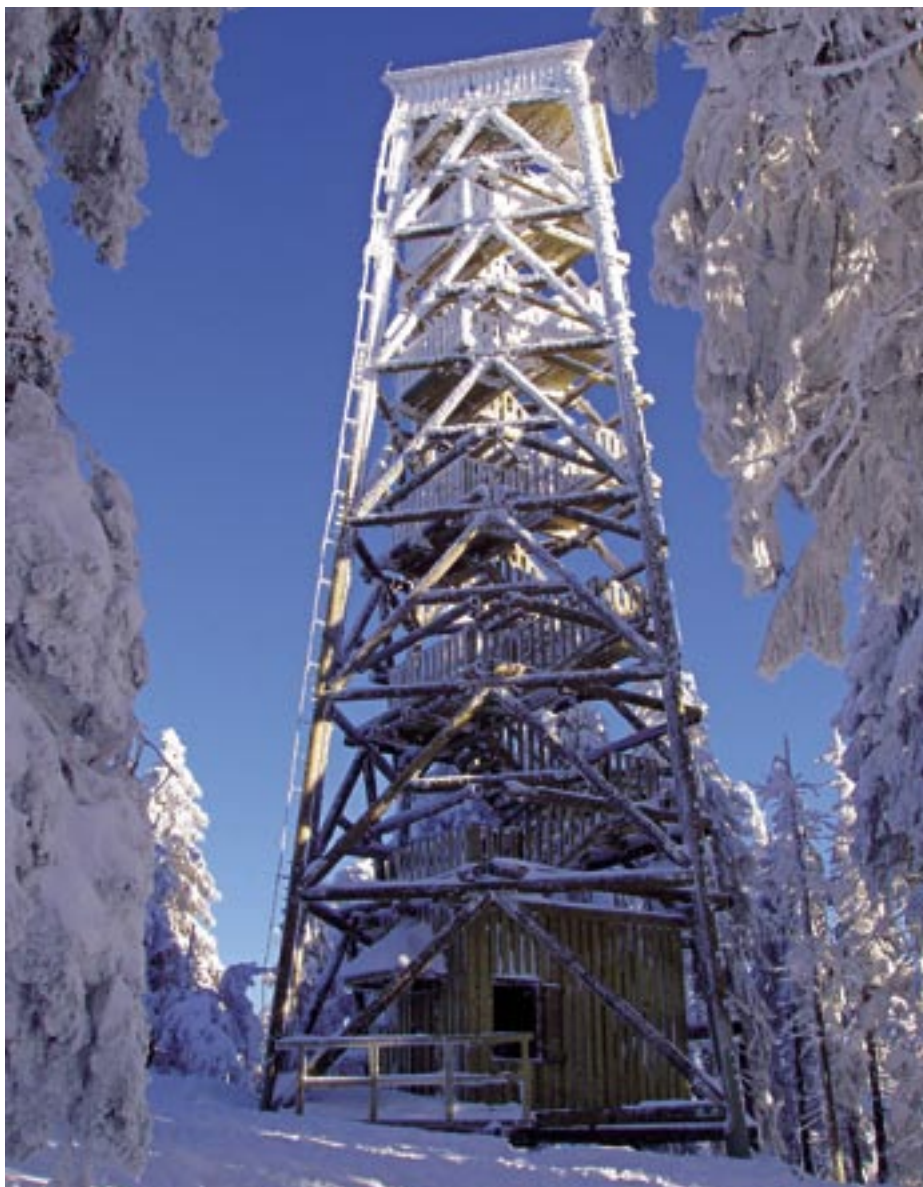
Obr. 1.33 Dřevěná konstrukce rozhledny na Boubíně [1]
