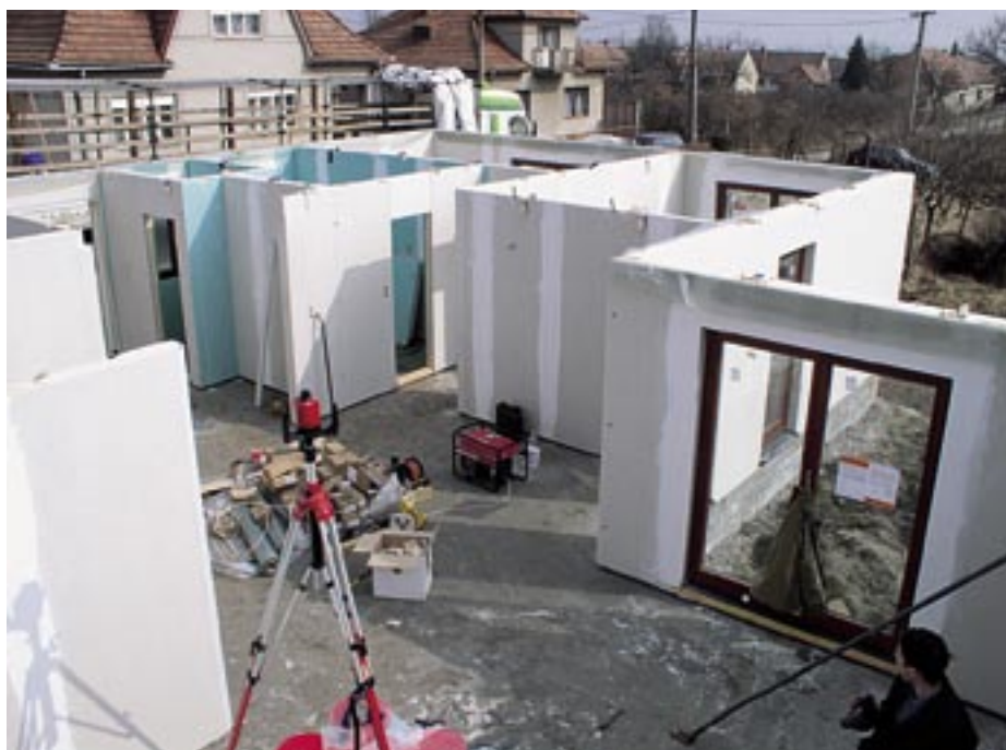
Obr. 4.4 Montáž stěnových panelů [4]
