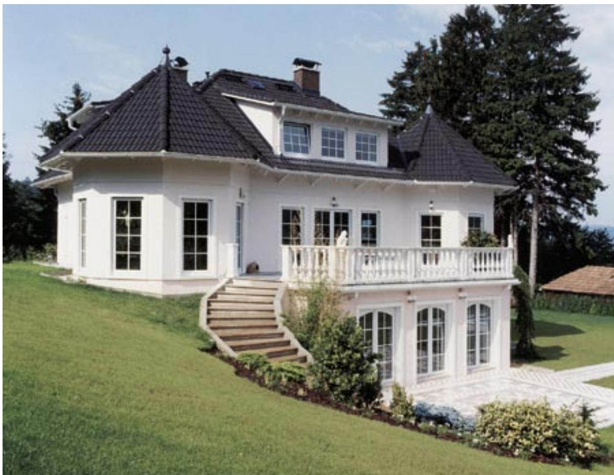
Obr. 4.21 Na první pohled masivní cihlová budova, ve skutečnosti dřevostavba z panelů [22]
