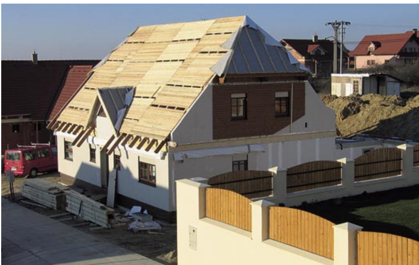
Obr. 4.14 Finalizace panelového domu z exteriéru [4]
