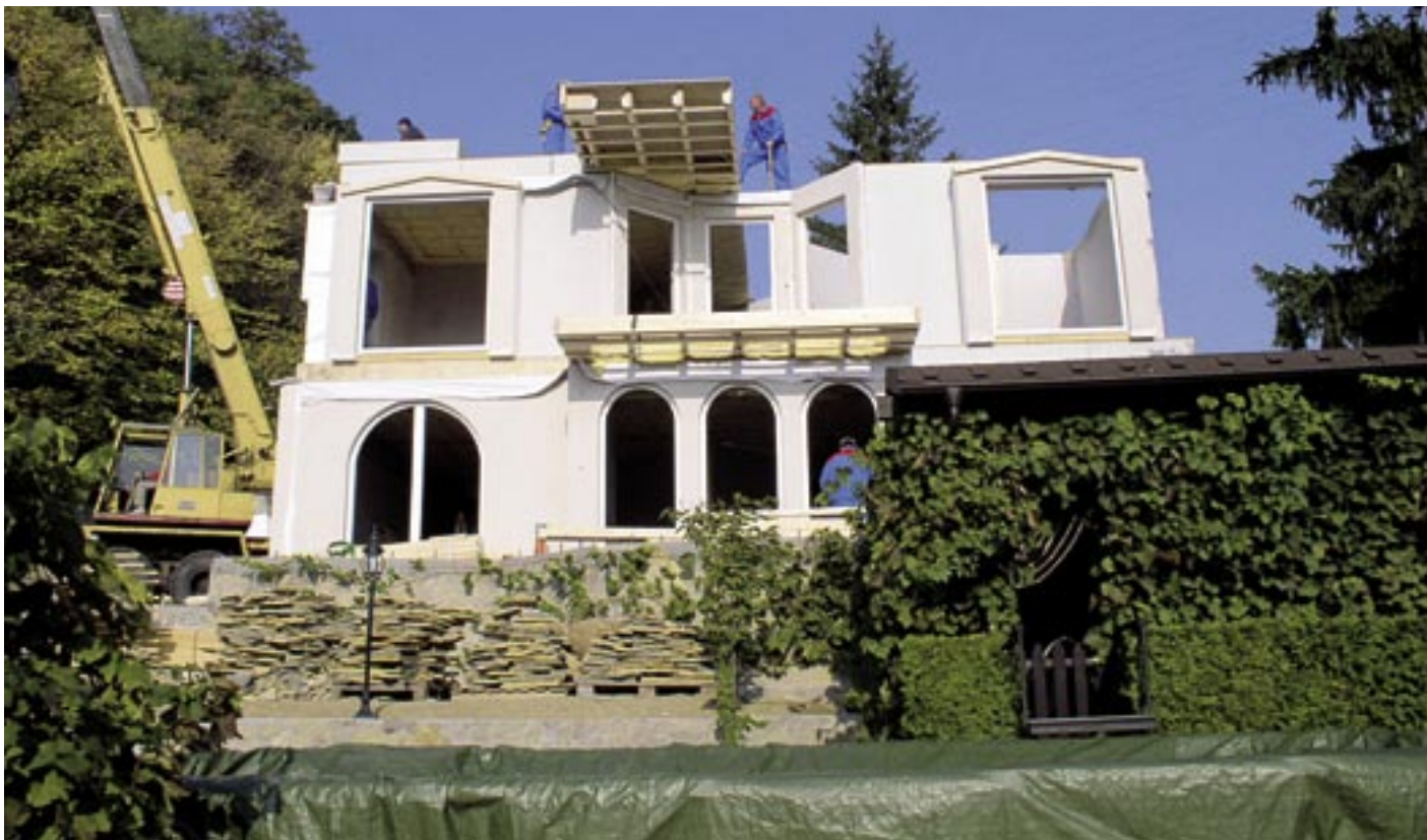
Obr. 4.16 Montáž stropních panelů [4]
