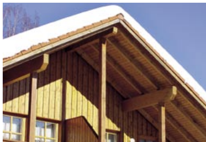
Obr. 2.60 Podepření vaznic při vyložení [1]
