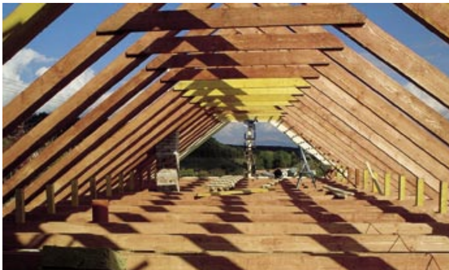
Obr. 2. 65 Vazba hambalkového krovu [1]
