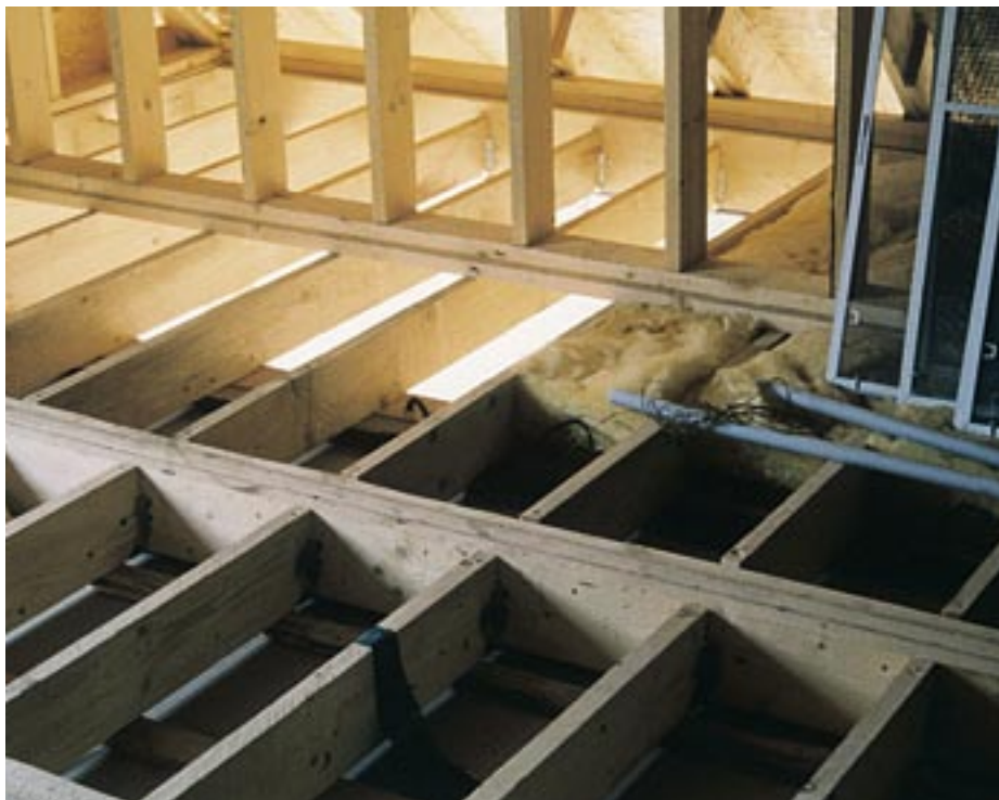
Obr. 2.47 Kvůli tepelné ochraně v místě stropu nad vnějším prostředím se celý prostor mezi stropnicemi vyplní tepelnou izolací [1]
