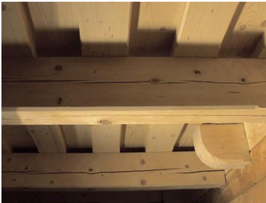
Obr. 2.39 Přírodní dřevo v příznané konstrukci trámového stropu [8]
