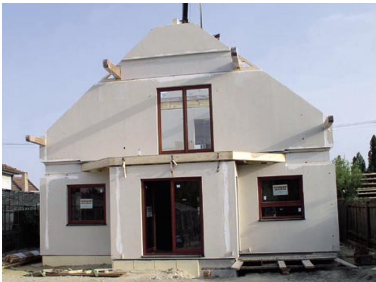
Obr. 2.32 Montáž kompletovaných panelů [4]
