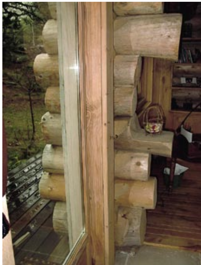
Obr. 2.10 Ztužení ostění proti vyboulení [43]
