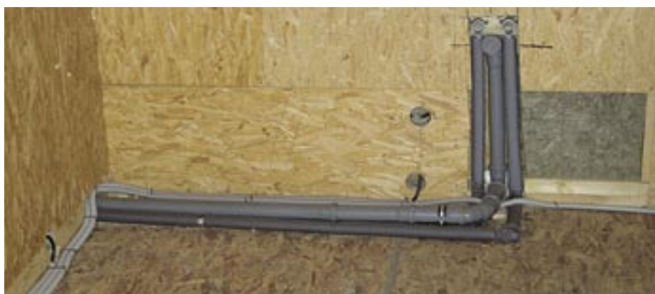
Obr. 4.18 Montáž rozvodů zdravotnické je ve dřevostavbě poměrně jednoduchá [1]
