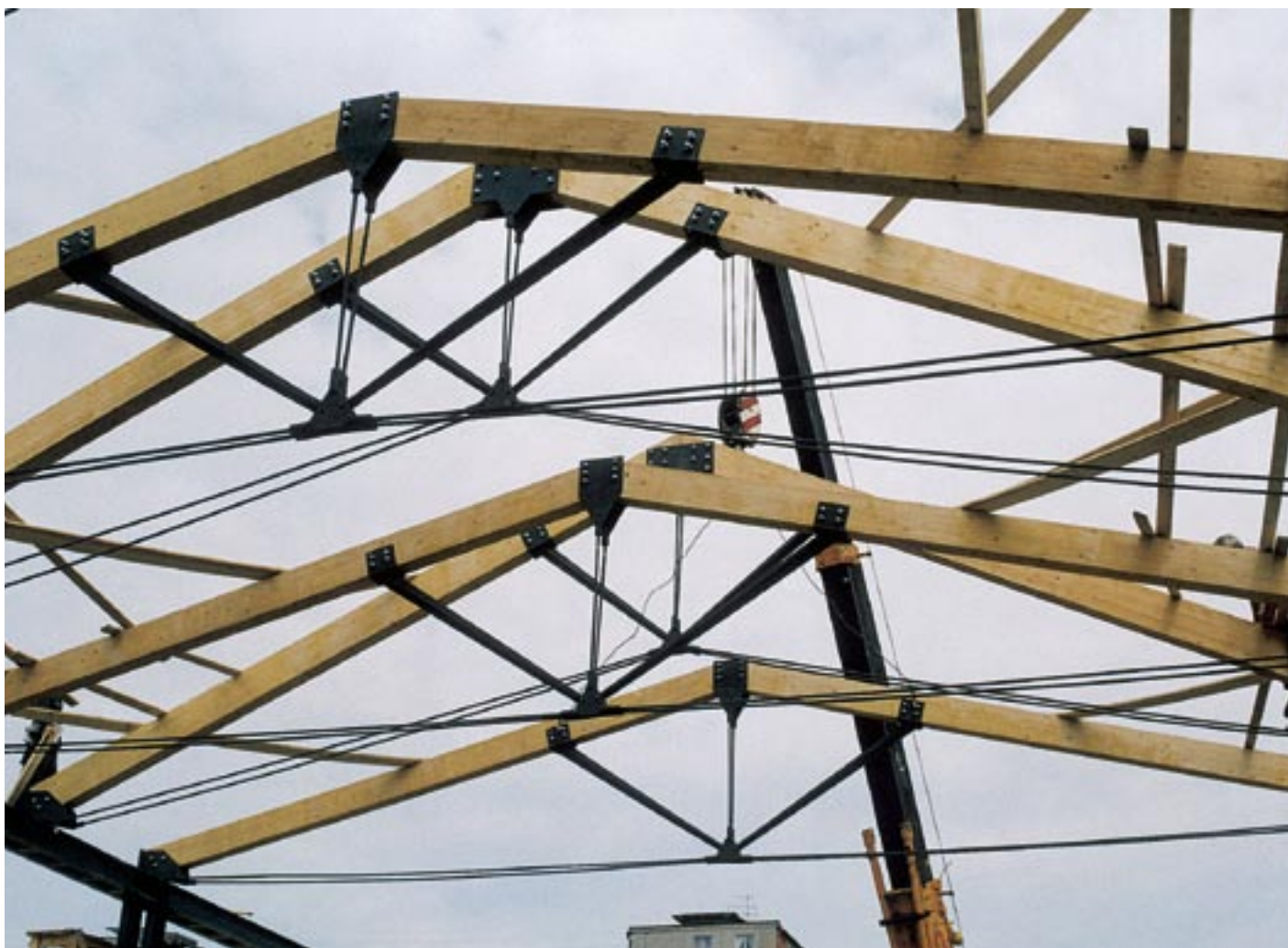
Obr. 2.71 Spřažený příhradový dřevo-ocelový vazník [1]
