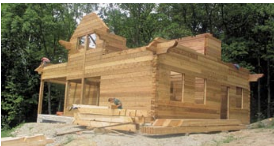
Obr. 4.30 Stavba srubového domu novodobé soustavy z cedrového dřeva [17]
