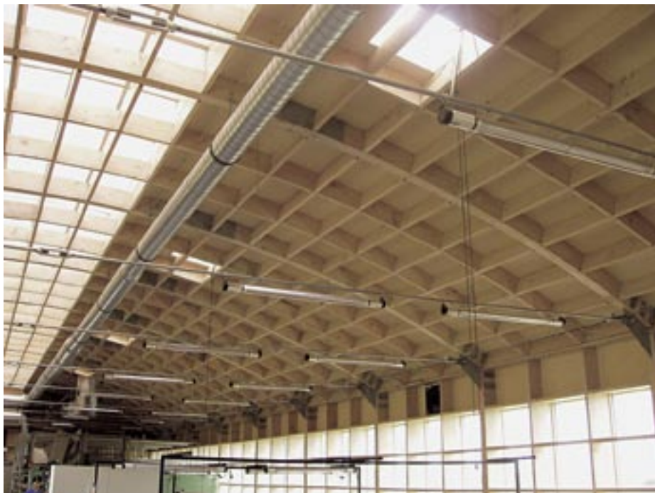
Obr. 1.30 Pohled na úspornou konstrukci zastřešení (výrobní svítidel Černochovo Praha) [2]
