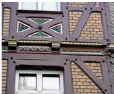
Obr. 2.34 Detail hrázděné stěny [1]
