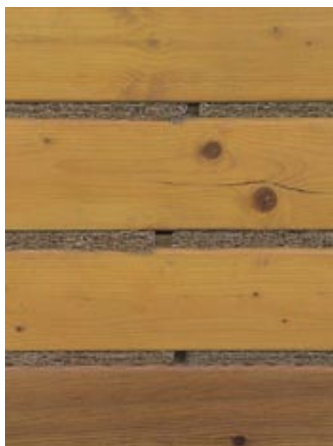
Obr. 2.8 Těsnění ložné spáry hraněného srubu na bázi kokosové vlny [8]
