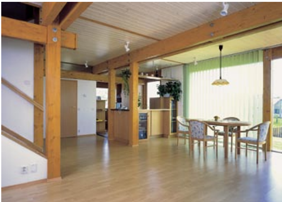
Obr. 3.5 Příklad rámové konstrukce z lepeného dřeva [21]
