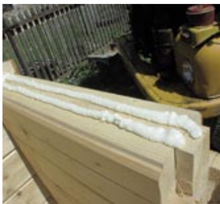
Obr. 4.31 Těsnění spojů vypěnitelným tmelem [17]
