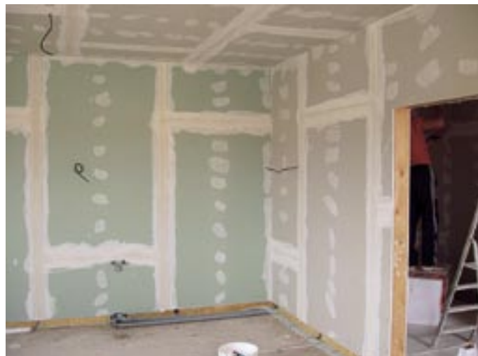
Obr. 4.13 Finální sádkartonový obklad panelu provedený na stavbě [1]
