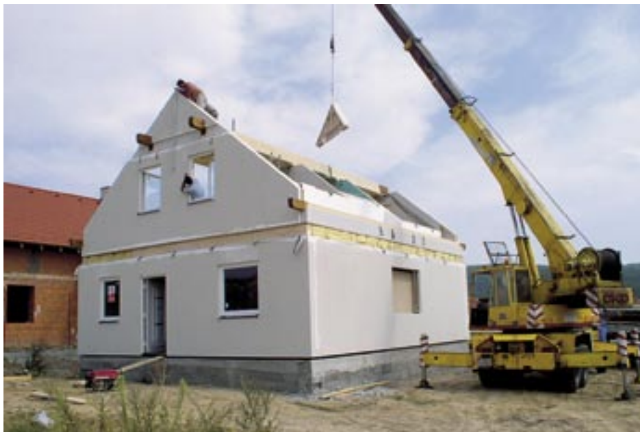
Obr. 4.1 Příklad montáže panelového prefabrikovaného domu [4]
